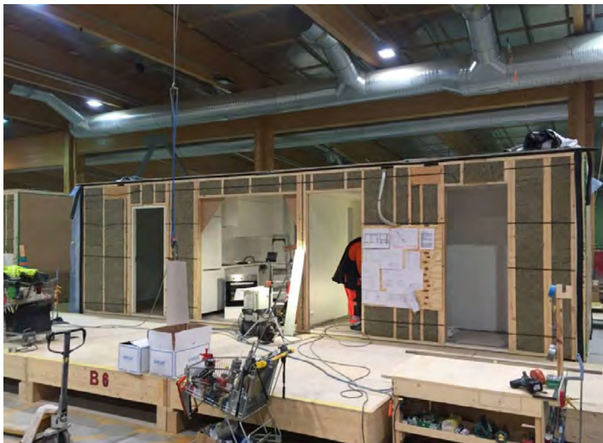
Tilaelementtirakenteiden valmistusta, kuva Puuinfo Oy.
