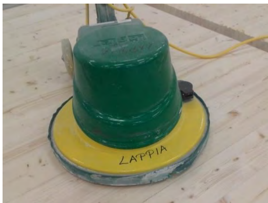
Levyypinnan hionta nauhahiomakoneella Kuvat Ammattiopisto Lappia
