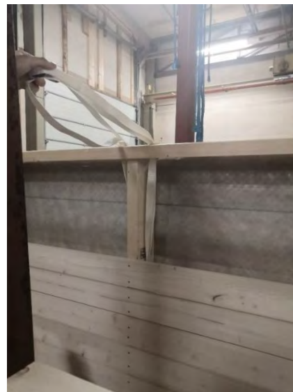
Kuvassa näkyy nostoraksin kiinnitys elementtiin. Tässä tapauksessa nostoraksi laitetaan kiinni tuuletusrakorimaan, josta se tuodaan vaakapuun läpi molemmin puolin pystyrimaa. Toinen vaihtoehto on kiinnittää se runkotolppaan. Kuvat Jukkatalo Oy.
