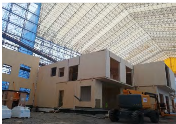
CLT-rakenteinen tilaelementtirakennus, kuva Rakennuspartio Sebastian Hallén.
