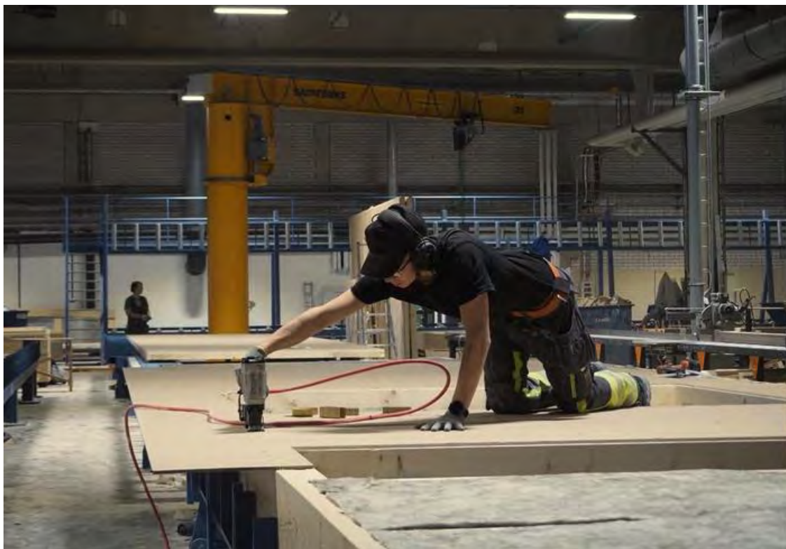
Levyt kiinnitetään runkoon runkotolppiin. Runkotolppajako k 600 mahdollistaa sen, että 1200 mm leveät levyt saadaan asennettua kokonaisena. Levyjen katkaisut tehdään aukkoihin ja reunoille. Näin saadaan levyjen ehyet saumat tiiviisti toisiaan vasten keskellä elementtiä. Kuva Kiiruna Talot Oy.
