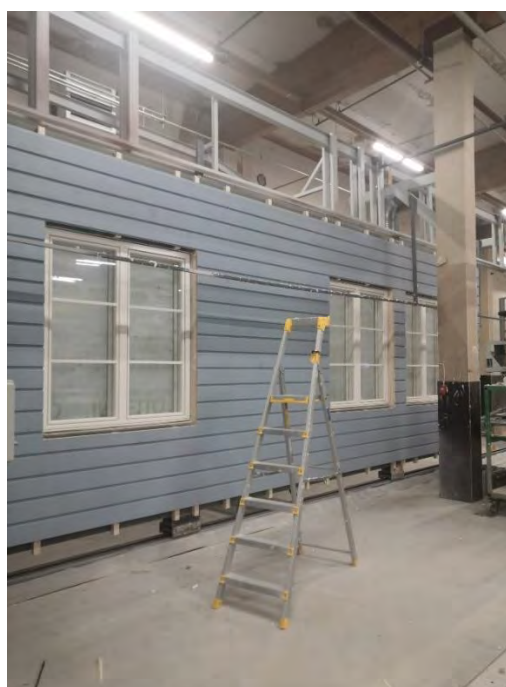
Ulkoverhouspaneelit asennettuina elementtiin, kuvat Jukkatalo Oy.
