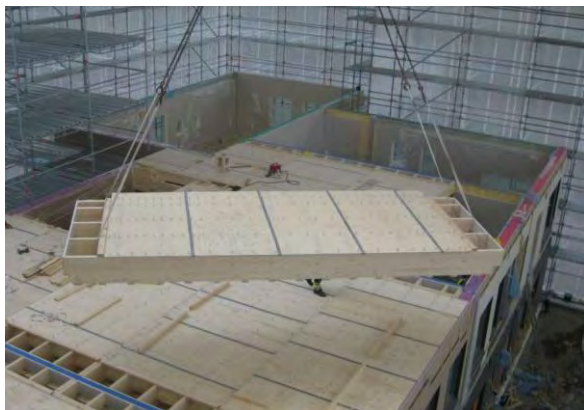
Suurelementtien nostoja, kuvat Puuinfo Oy.
