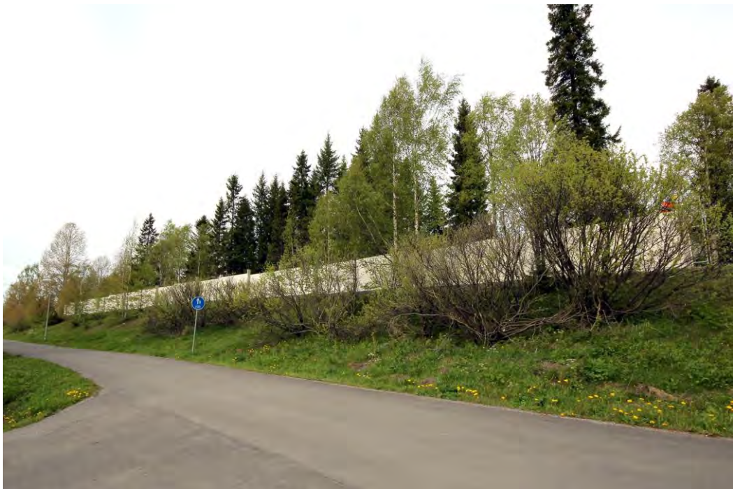
CLT-levyistä valmistettu meluntorjuntaseinä, mallinnus ja kuva Ammattiopisto Lappia
