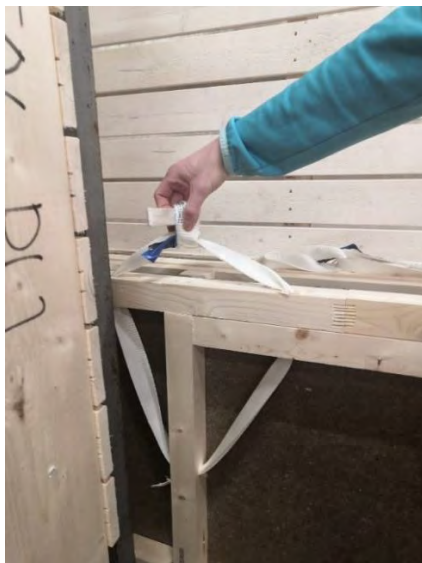
Kuvassa näkyy nostoraksin kiinnitys elementtiin. Tässä tapauksessa nostoraksi laitetaan kiinni tuuletusrakorimaan, josta se tuodaan vaakapuun läpi molemmin puolin pystyrimaa. Toinen vaihtoehto on kiinnittää se runkotolppaan. Kuvat Jukkatalo Oy.
