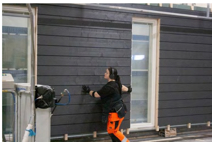
Seinäelementti valmiiksi pintakäsiteltynä, kuva Jukkatalo Oy.
