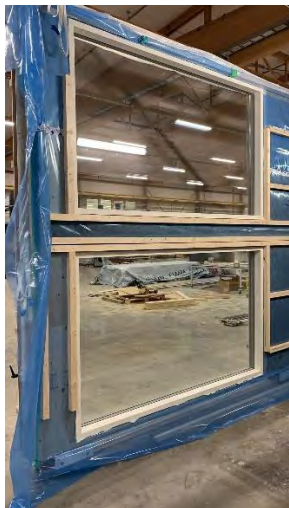
Ikkunat asennettuna elementtiin, kuva on sisäpuolelta katsottuna. Kuva Jukkatalo Oy.
