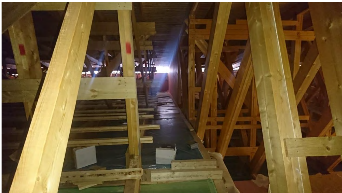
Kattoristikkorakenteinen yläpohja, kuva Keminmaan Puurakenne Oy.
